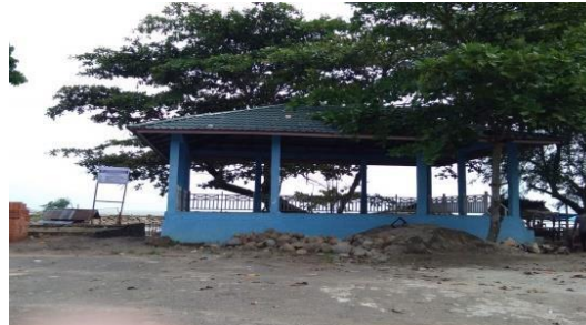
Gambar IV.5 Bangunan Pentas di Pantai Tugu Air Bangis
