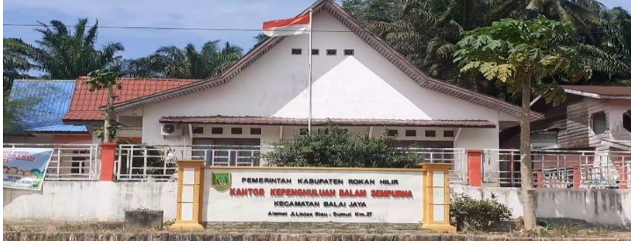
Kantor Kepenghuluan Desa Balam Sempurna Kecamatan Balai Jaya Kabupaten Rokan Hilir
