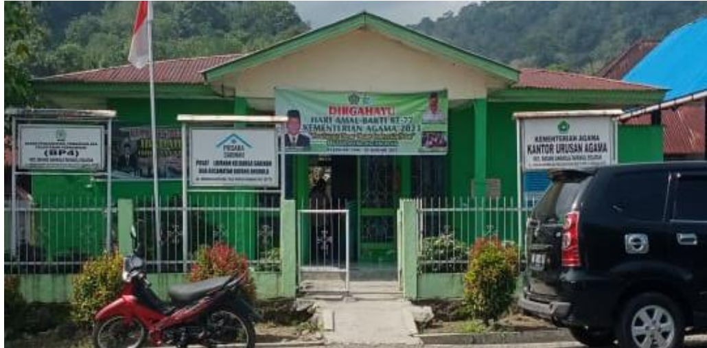
Observasi lapangan bagian depan Kantor Urusan Agama Kecamatan Batang Angkola pada tanggal 23 Agustus 2022
