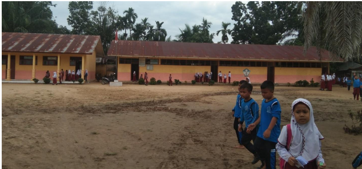
Gambar. 2 Bangunan SDN 1106 Padang Garugur Kabupaten Padang Lawas
