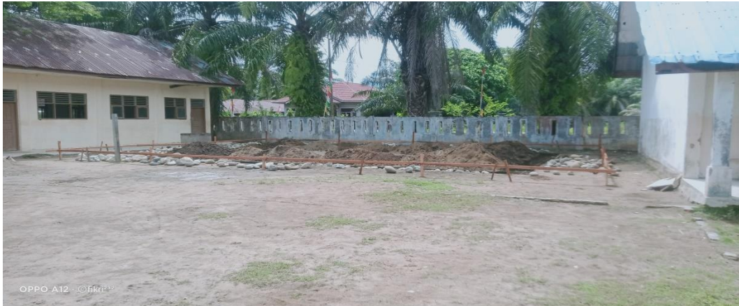
Gambar 3.2 Ruang IT (Dalam Pembangunan)
