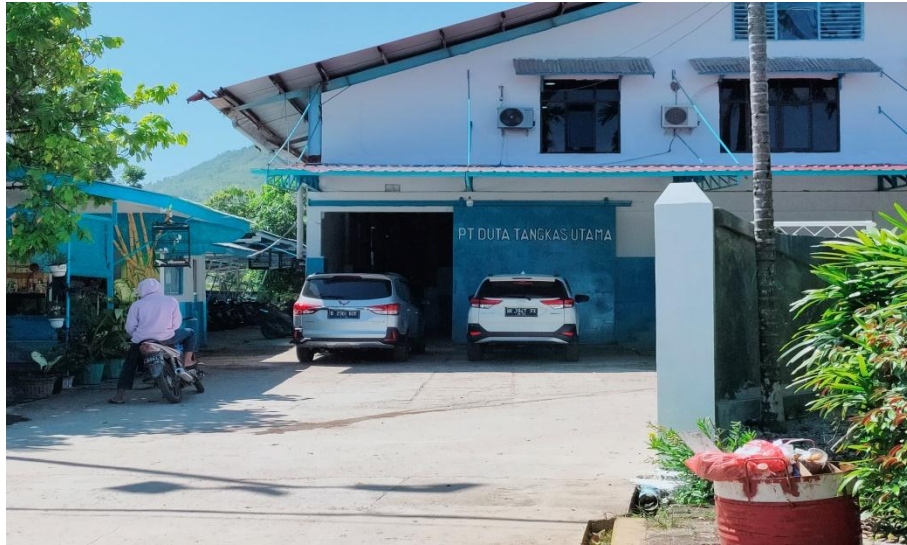
banguna tampak luar PT. Duta Tangkas Utama
