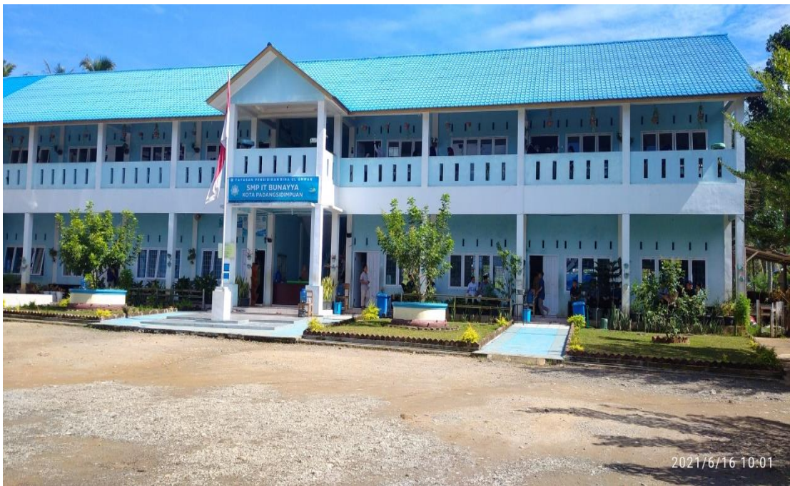
Gedung SMP IT Bunayya Padangsidempuan
