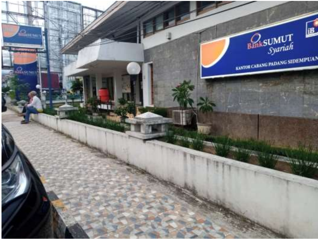
Observasi Bangunan PT. Bank Sumut Cabang Syariah Padangsidempuan.
