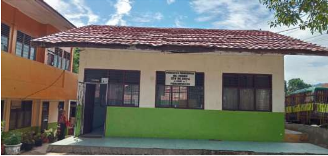
Ruang Guru SD N 200114 kantin Padangsidempuan Utara
