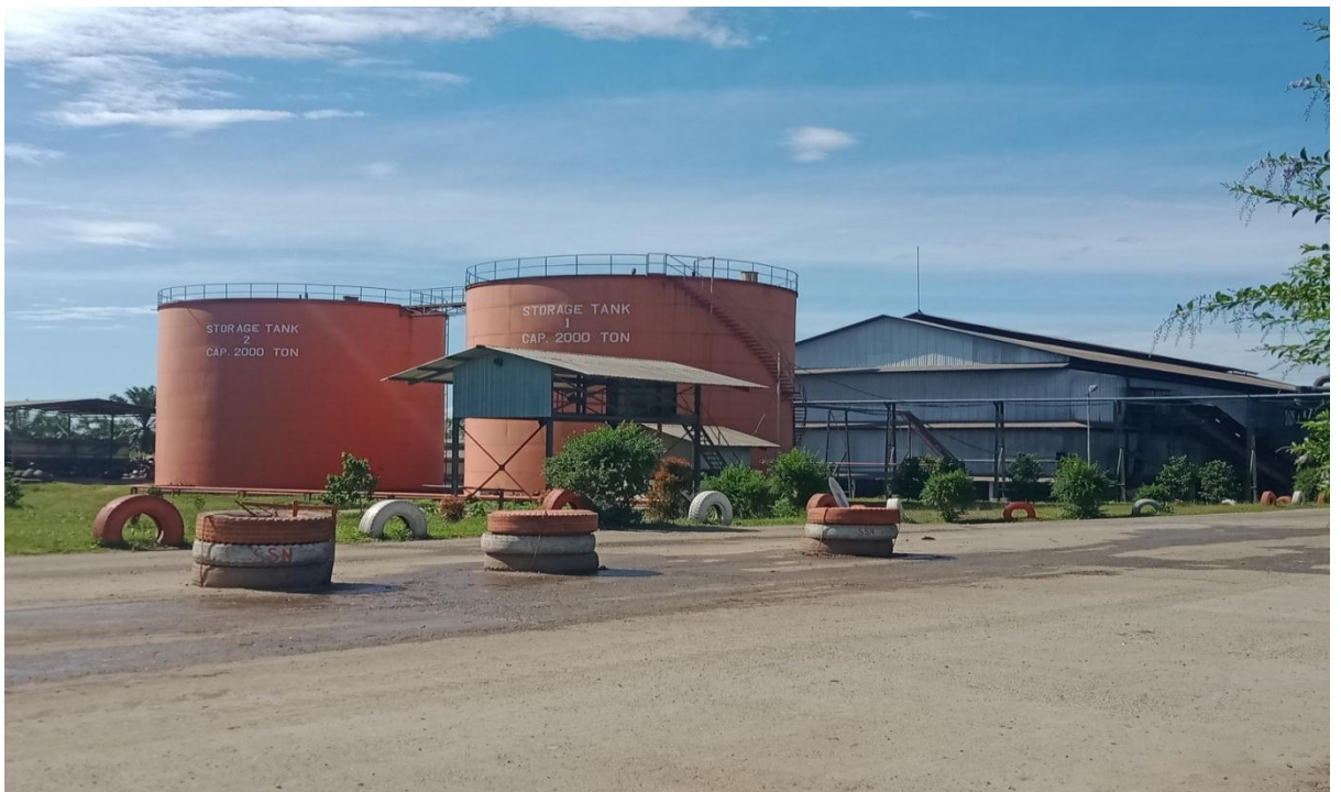
Dokumentasi Storage Tank PT. Sumber Sawit Nusantara Kabupaten Padang Lawas Utara.
