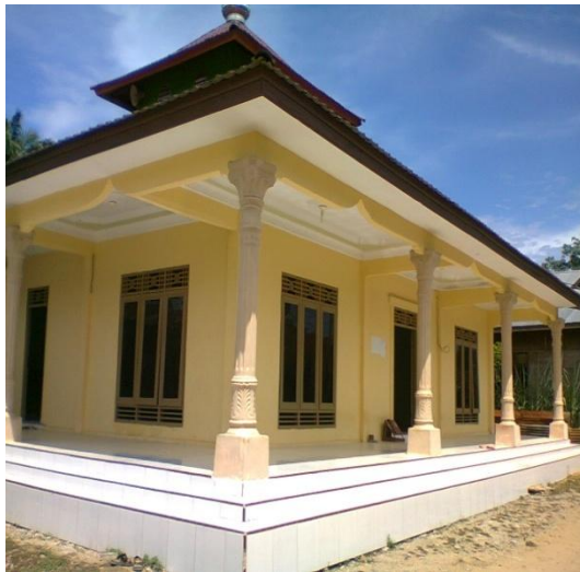
Hasil dokumentasi masjid desa Teluk Panji Kecamatan Kampung Rakyat Kabupaten Labuhanbatu Selatan
