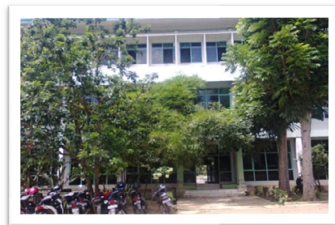
Gedung Aula Tampak dari Belakang
