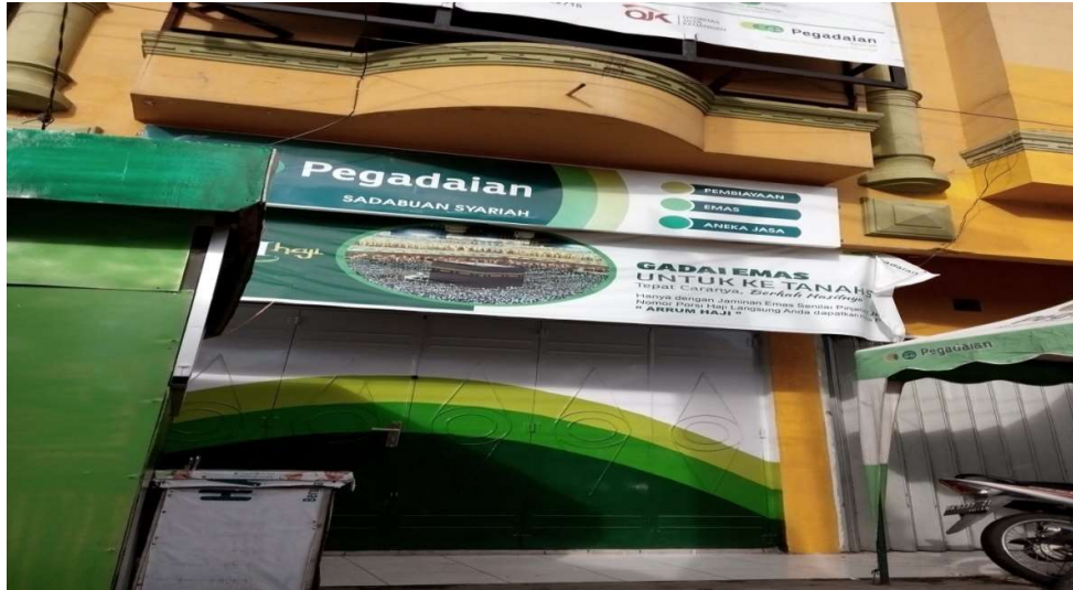
Gambar 1. Gedung PT. Pegadaian Syariah Unit Sadabuan Padangsidimpuan
