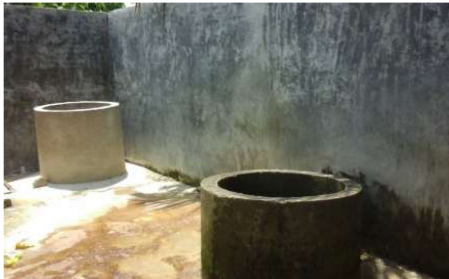
Gambar II: Kondisi Keadaan Sumber air di surau.
