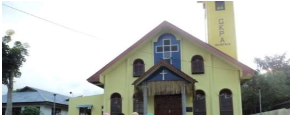
Gambar II: Kondisi Tempat Ibadah di desa Huta Raja
