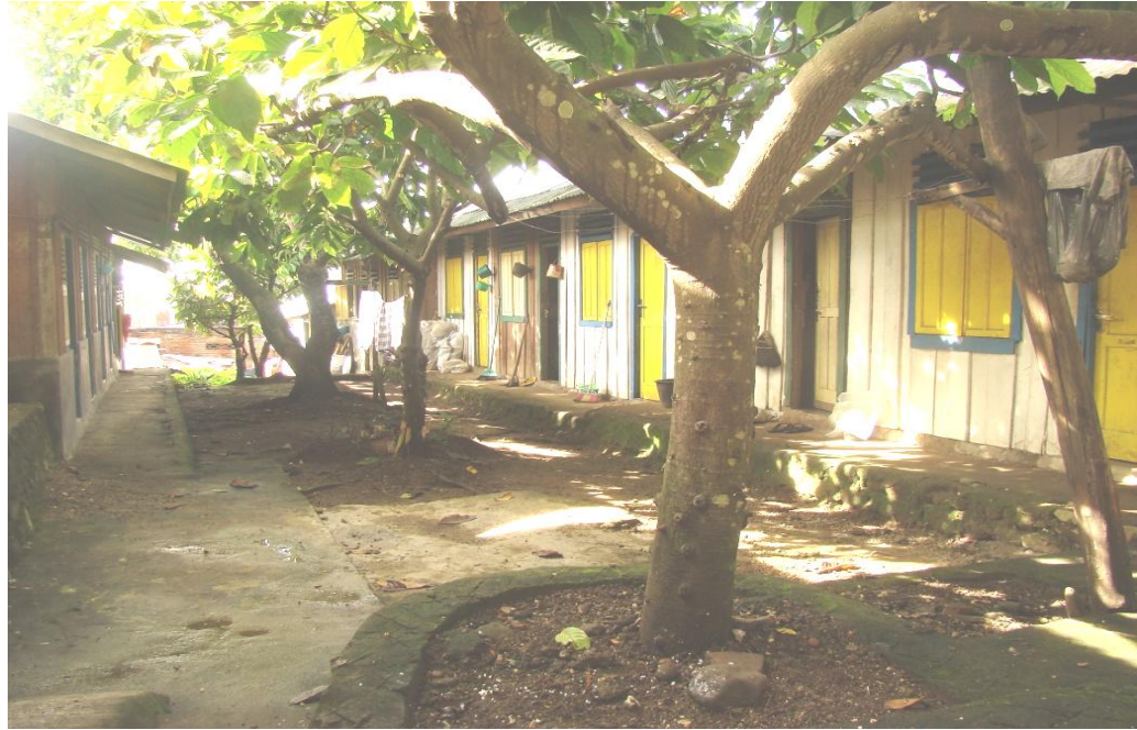
Gambar Bangunan Sisi Tengah dan Sisi Kanan Didalam LKS Lanjut Usia Ma'arif Muslimin Padangsidempuan
