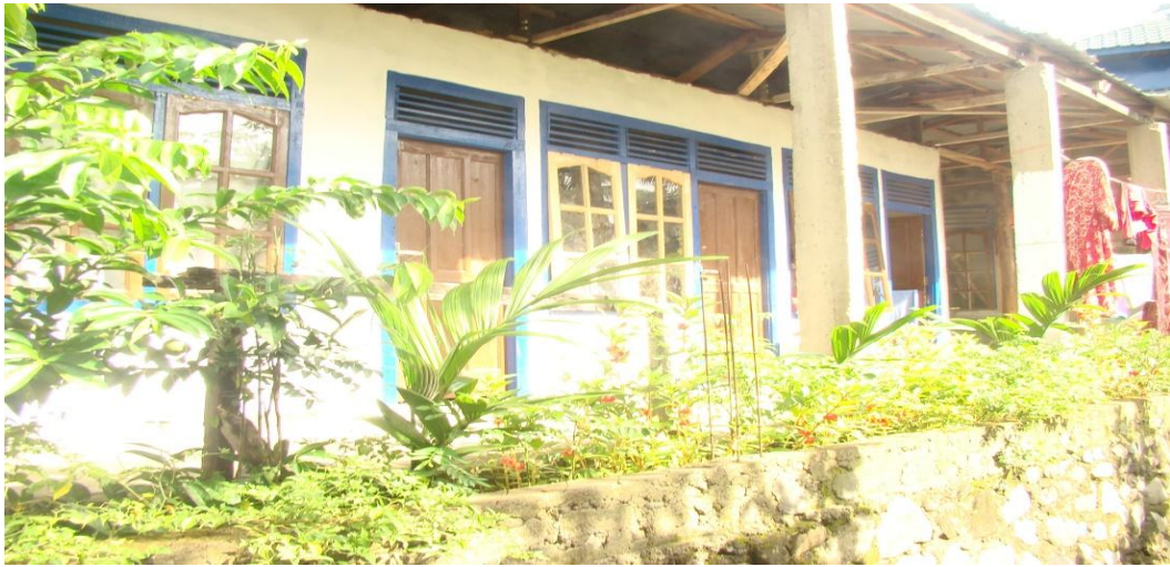
Gambar Bangunan Sisi Belakang LKS Lanjut Usia Pondok Ma'arif Muslimin Padangsidempuan
