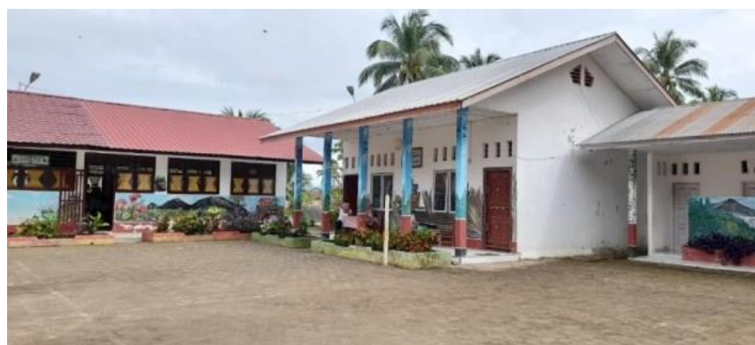
Ruang Guru dan Ruang Perpustakaan
