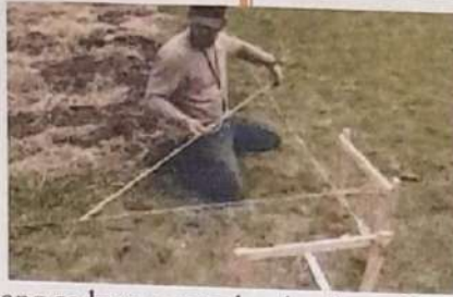
Gambar 1. Seorang tukang sedang mengukur kesikuan Rencana pondasi bangunan
