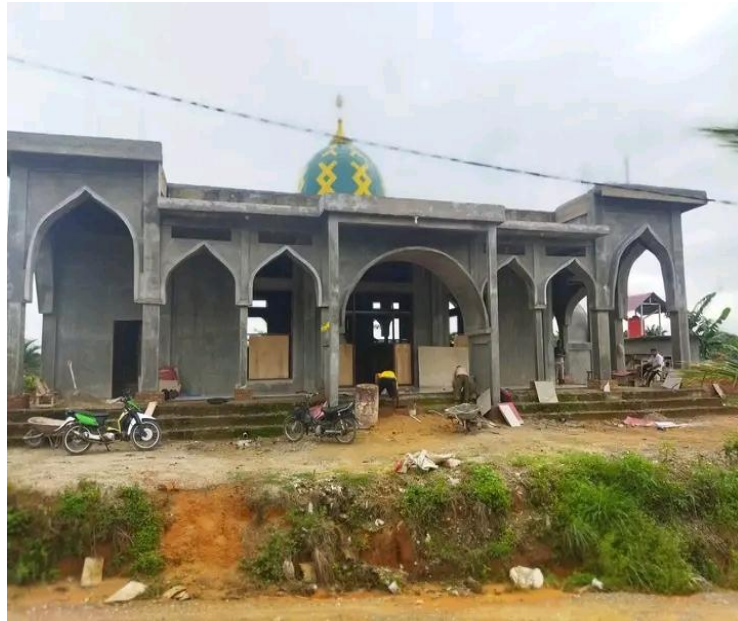
Gambar 7. Keadaan masjid Ar-Rahman Proses Renovasi
