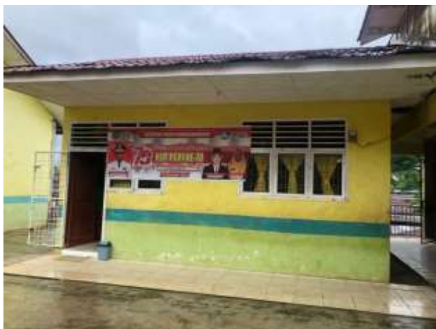
Gedung SD Negeri 200207 Padangsidempuan.
