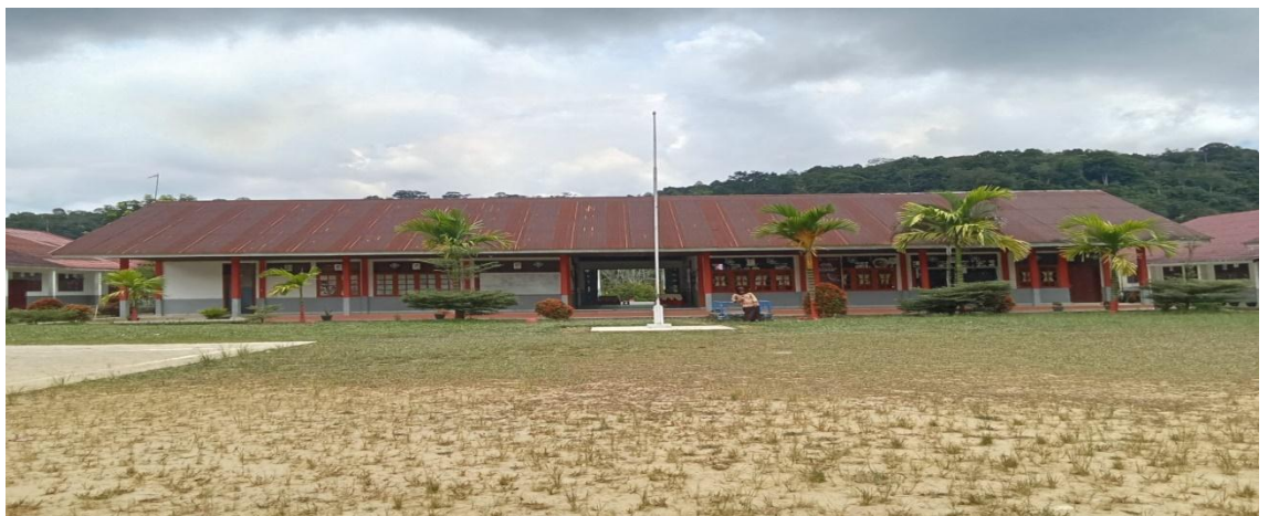
Kondisi Lapangan Sekolah SMA Negeri 1 Sosopan
