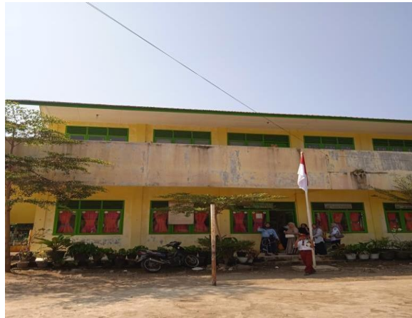
Gambar 1.3: Bangunan SD Negeri 200402 Sabungan Jae
