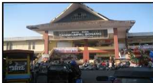
Gambar pasar raya sangkumpul bonang sesudah dibangun
