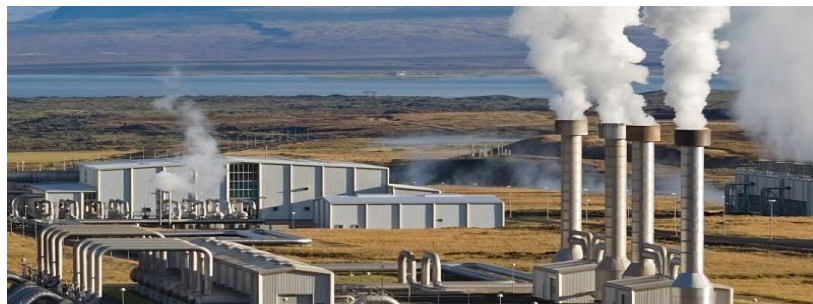
Gambar 2.5 PLTG (Pembangkit Listrik Tenaga Geothermal) Sumber: Wira Griya. co.id
