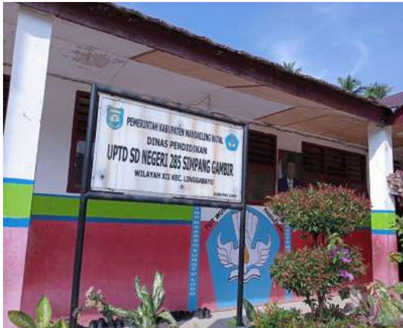
Gambar 1 Gedung SD Negeri 285 Simpanggambir
