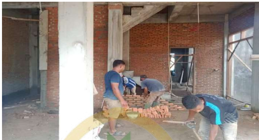
Pembangunan Rumah Produksi Desa Aek Tuhul 2 September 2021
