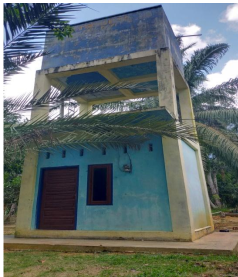
Gambar IV.2 Bangunan PAMSIMAS di Desa Aek Raso Afdeling A
